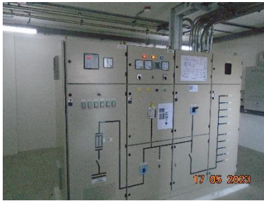
ระบบตัดกระแสไฟฟ้าอัตโนมัติ
