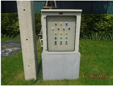
ภาพที่ 2-19 ตู้ควบคุมการระบายน้ำและบ่อน้ำของโครงการ
